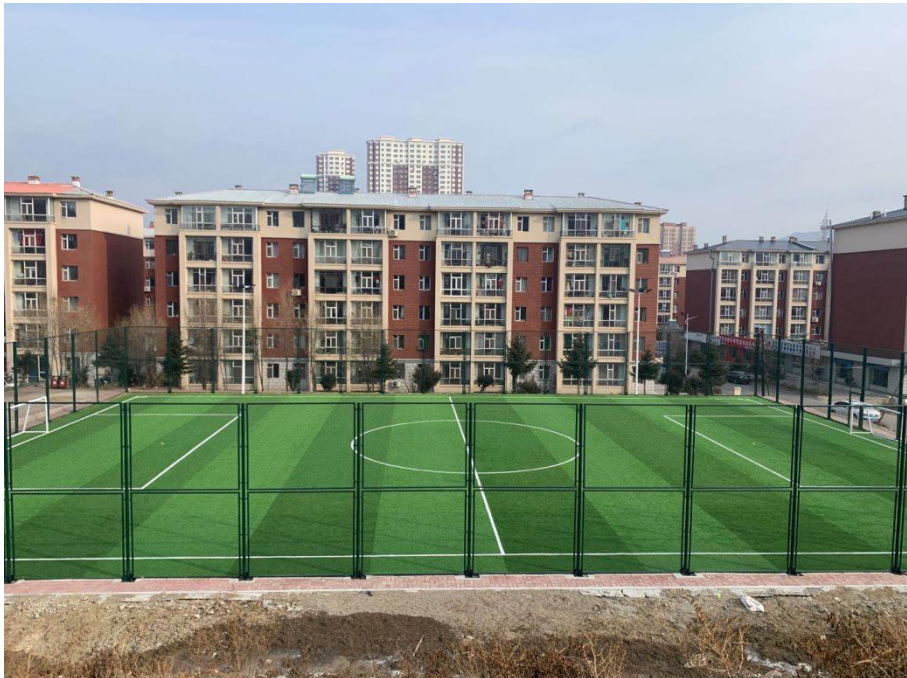
宏宇小区南侧建设后
